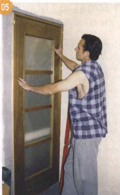
05 Контрольная проверка дверным полотном выявит все огрехи в установке коробки. Эту операцию лучше выполнять вдвоем, чтобы вести осмотр со всех сторон.
