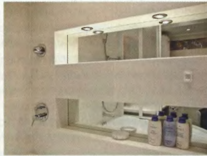
Пространство за перегородкой использовано для устройства ниш с полками.
