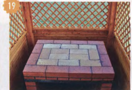
19 Глухой под мангала отделан шамотным кирпичом, положенным плашмя.
