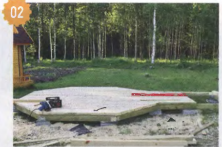
02 Обвязка и настил пола обработаны антисептиком «Сенеж».
