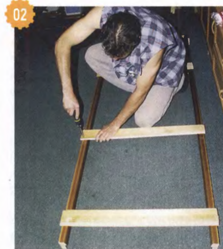
02 Распорки крепил к боковым брускам саморезами поближе к наружным кромкам. Следы от саморезов закроют наличники.
