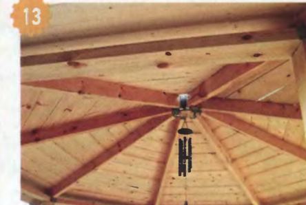
Шатровая крыша. Вид снизу.
