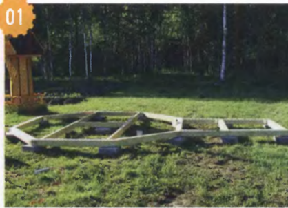
01 Нижняя обвязка установлена на столбики, набранные из тротуарных бетонных плиток.
