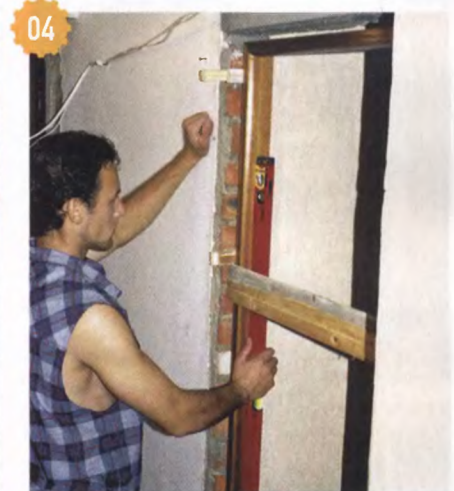
04 Подбивая клинышки и ориентируясь на уровень, выставил дверную коробку в проёме.
