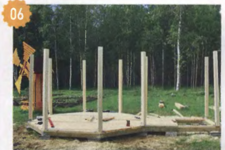
06 Крыша беседки держится на десяти столбах из бруса 100 × 100 мм.
