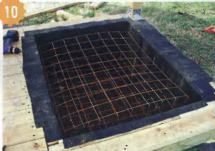
Фундамент мангала армирован стальной сетной и прутком Ø 10 мм.
