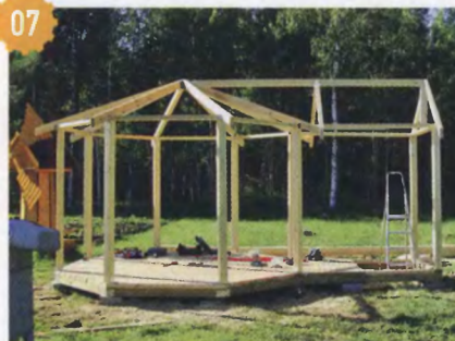
07 Верхняя обвязка и стропила подняты на столбы и закреплены.
