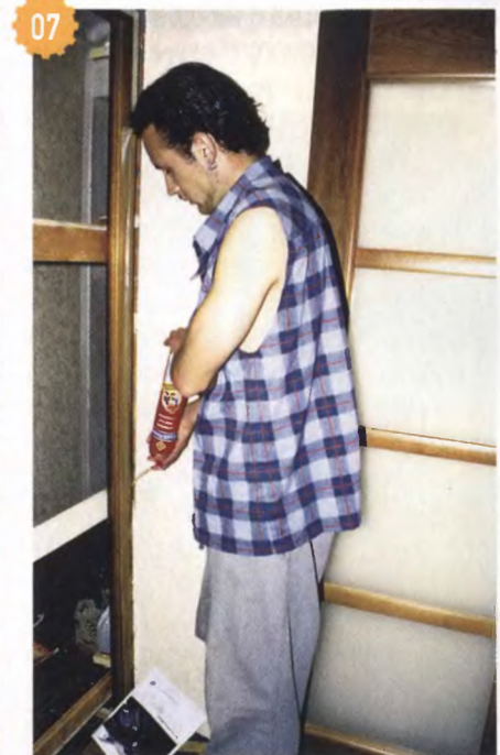
07 Кроме монтажной пены дополнительного крепления коробки к стенам не требуется. Мне показалось, что заполнять полости между стеной и коробкой удобнее снизу вверх.
