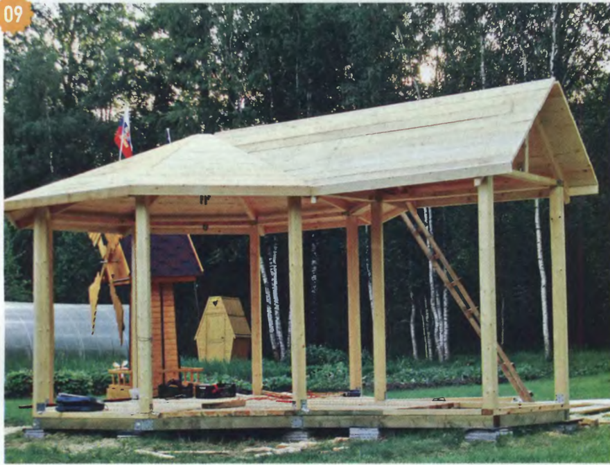
Под мягкую черепицу смонтирован сплошной настил.
