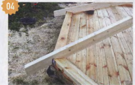
04 Для плотной стыковки стропил с обвязкой в стропилах сделаны треугольные выборки.
