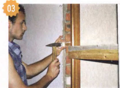
03 Из обрезков досок и брусков выстругал 20 клинышков, которыми зафиксировал дверную коробку в проёме. Устанавливал клинышки вблизи распорок.
