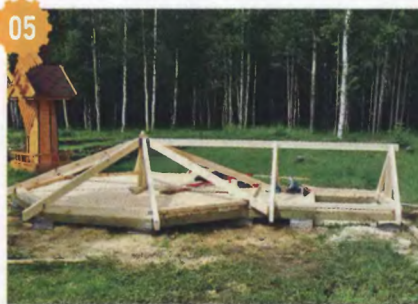
05 Подгонять детали стропильной системы и обвязки лучше внизу, на половом настиле.
