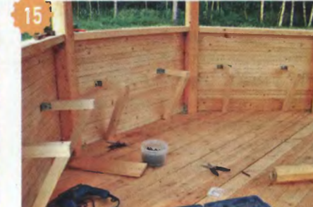
Для устройства скамьи к стенам беседки прикреплены кронштейны с раскосами из деревянного бруска.
