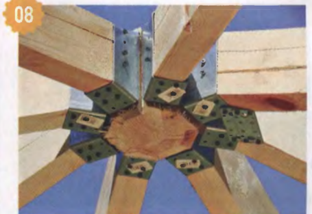
08 Центральный замок стропильной системы. Вид снизу.
