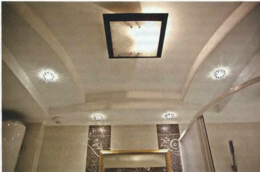
Многоуровневый потолок помог спрятать потолочные балки. Светильники позволяют менять освещённость ванной комнаты в зависимости от ситуации.
