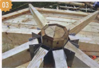
03 Центральный замок стропильной системы беседки.
