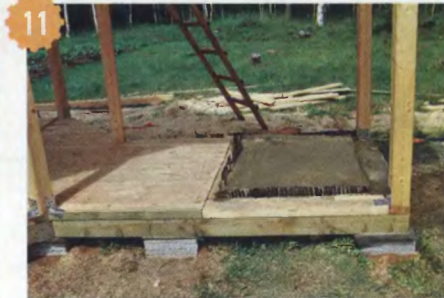
Бетон в фундамент уложен до уровня настила пола беседки.
