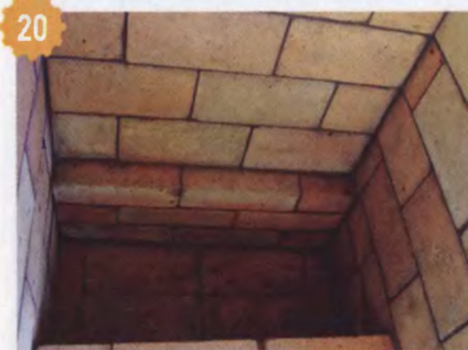
20 Топка мангала обложена шамотным кирпичом на ребро.
