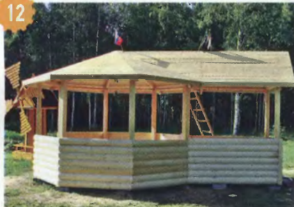
Нижняя часть стен беседки обшита блокхаусом.
