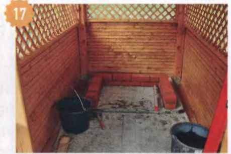
17 Под первый ряд кирпичей мангала положен рубероид в качестве гидроизоляции.
